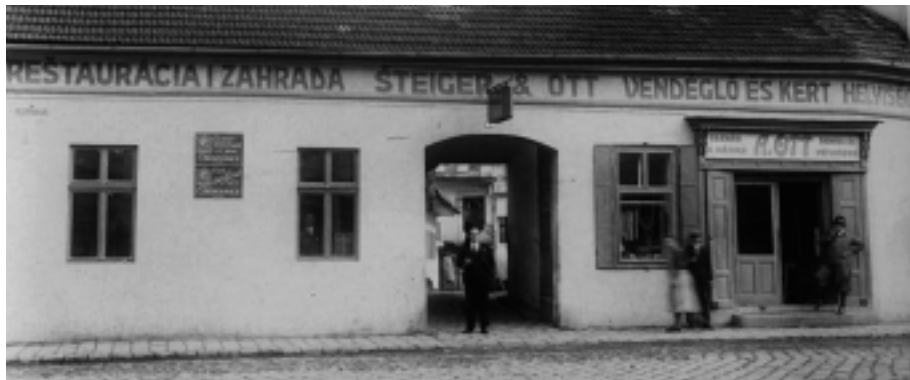
Staršia (pôvodná) budova súkromnej reštaurácie Steiger a Ott na Gusztínyiho ulici č. 1 pred demoláciou.
